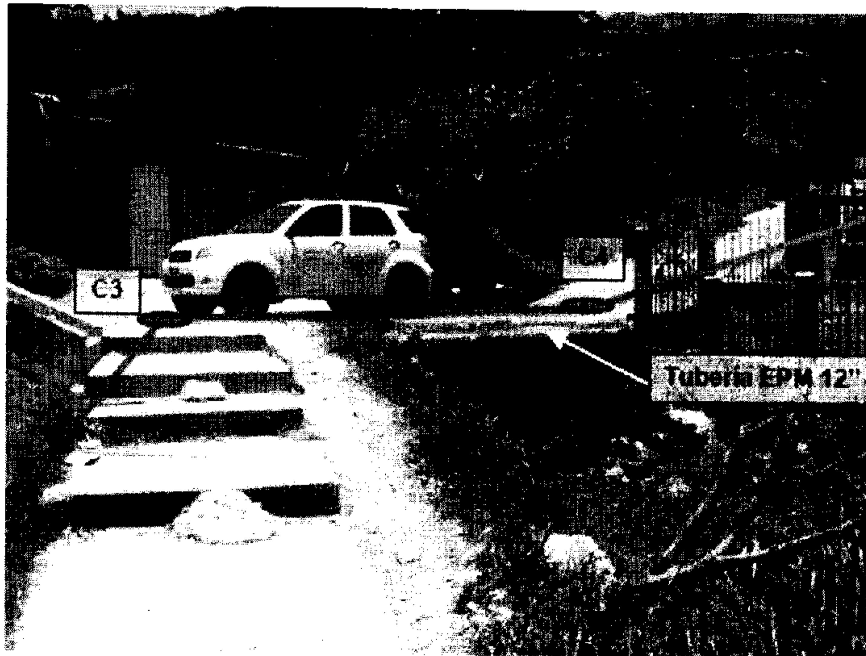
Foto 5. Localización de la obras subfluvial. Fuente: Anexo del Oficio N°. 016621 de 26 de julio de 2013
